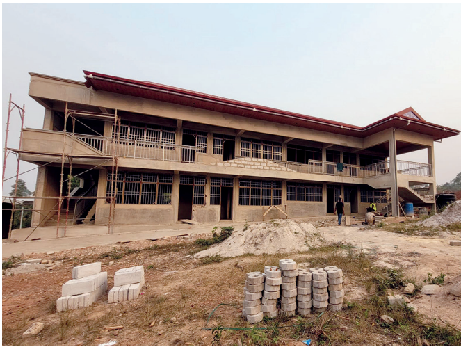
Fortschritte beim Bau des Lehrerhauses in Chiransa
